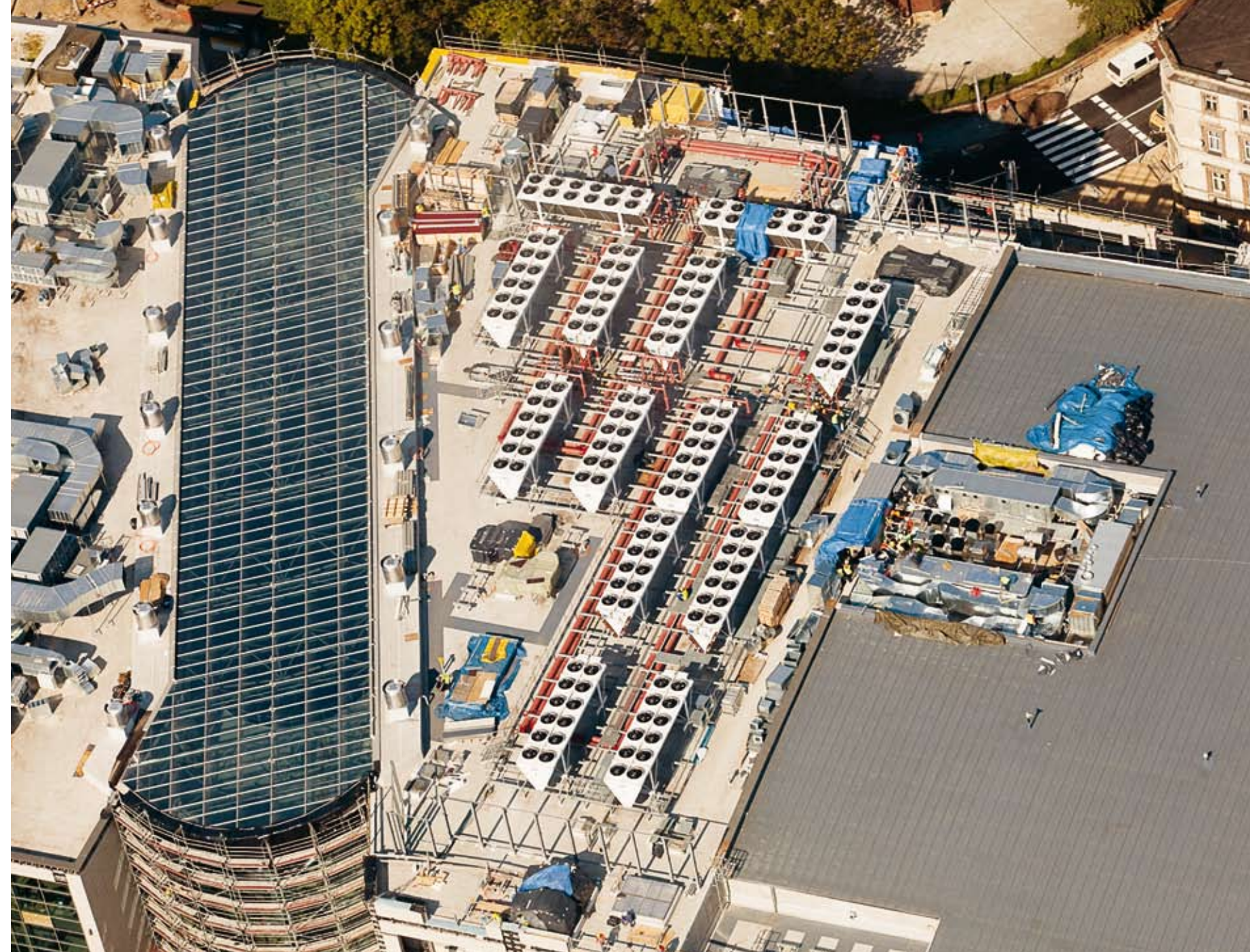
AGORÀ SHOPPING CENTER, BYTOWN. POLONIA - CONDIZIONAMENTO DELL'ARIA: 14 UNITÀ EHLD 1 - 12 MOTORI
