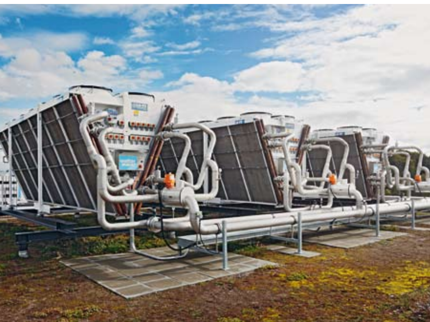
A SINISTRA A DESTRA: DRY COOLER DRY AND SPRAY® - SVIZZERA (FONTE: WALTER MEIER)
