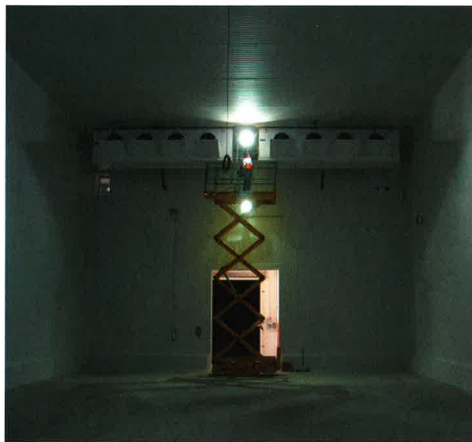
Foto 1: Luftkühler mit saugenden Ventilatoren
