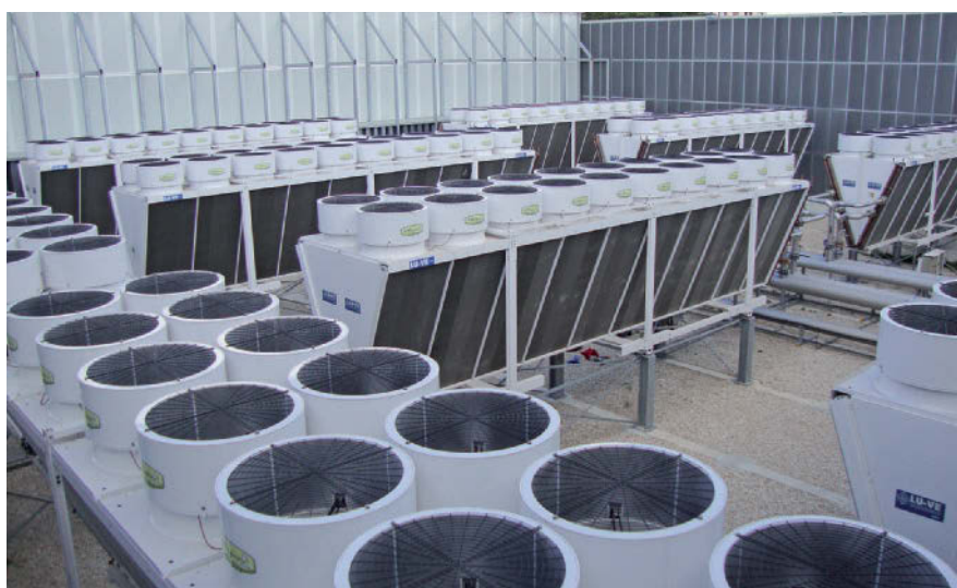
Dry coolers EHL "Giants" con silenziosi Whisperer® per condizionamento data center.
